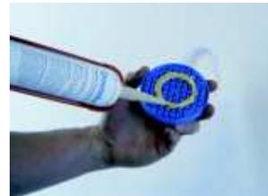
Pendant le fraisage conique presser la rondelle de fixation MTH ANELLO au ras du panneau isolant.
