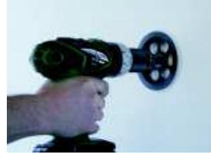
Appliquer de la colle MARCOTHERM COLLA PU sur la surface circulaire des rondelles de fixation MTH ANELLO. Si la rondelle de fixation MTH ANELLO n'est sollicitée que par une force transversale, il ne sera pas nécessaire de coller la rondelle.
